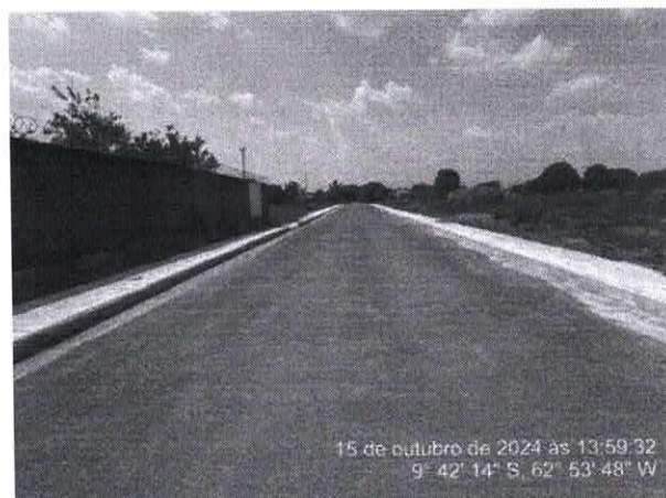
Foto 18 – Av Sebastião Dutra
