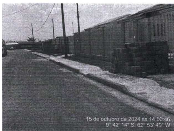
Foto 23 – Rua Oiti – Parte 02
