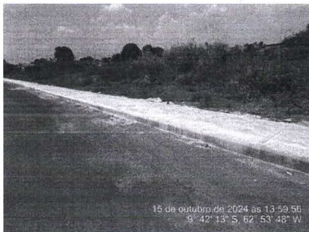
Foto 19 – Av Sebastião Dutra
