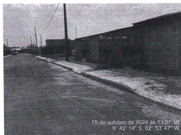
Foto 12 – Rua Oiti – Parte 01
