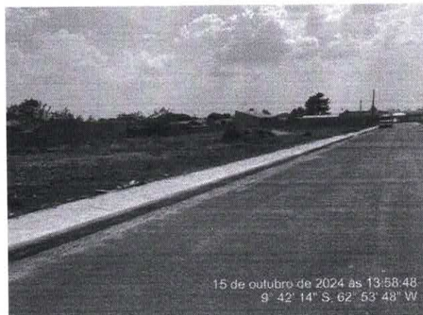
Foto 14 – Rua Oiti – Parte 01
