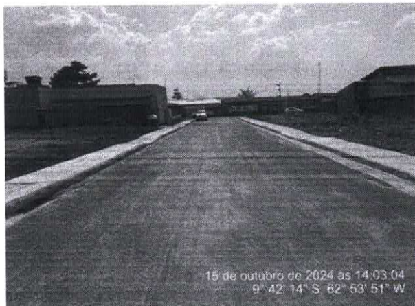
Foto 31 – Rua Oiti – Parte 03
