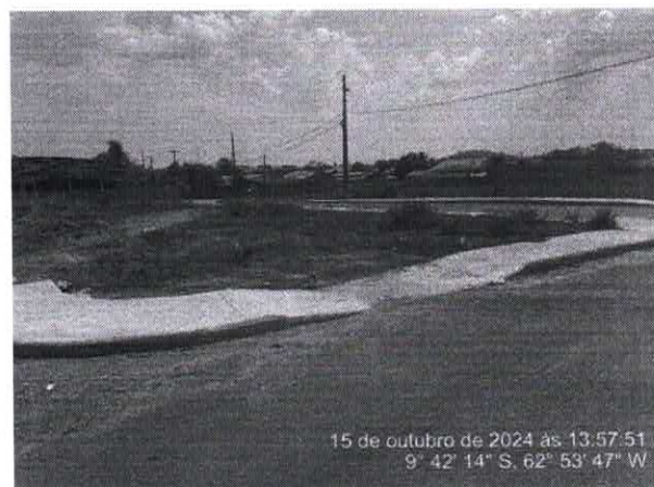
Foto 10 – Rua Oiti – Parte 01
