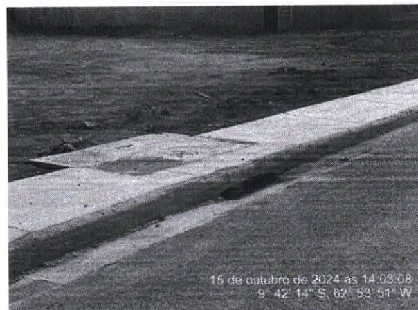
Foto 32 – Rua Oiti – Parte 03
