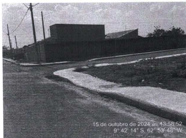
Foto 15 – Rua Oiti – Parte 01
