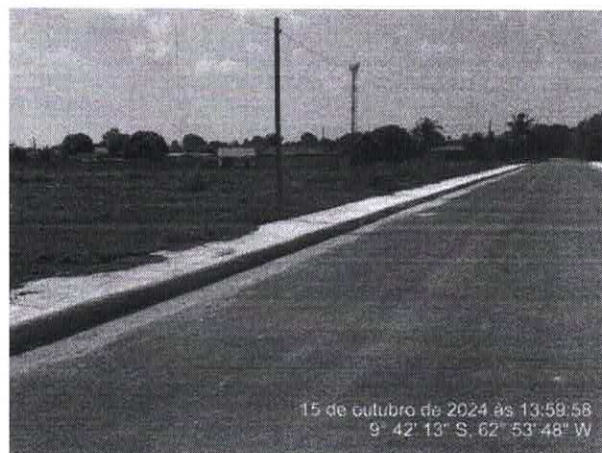
Foto 20 – Av Sebastião Dutra
