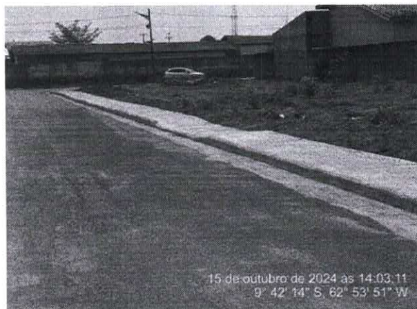
Foto 33 – Rua Oiti – Parte 03
