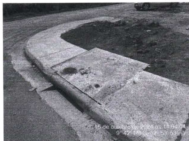
Foto 34 – Rua Oiti – Parte 03
