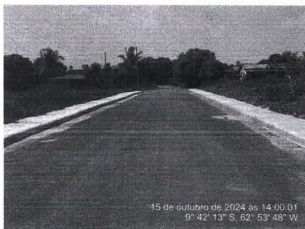
Foto 21 – Av Sebastião Dutra
