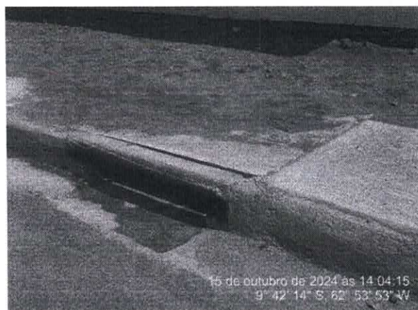
Foto 35 – Rua Oiti – Parte 03
