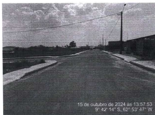
Foto 11 – Rua Oiti – Parte 01
