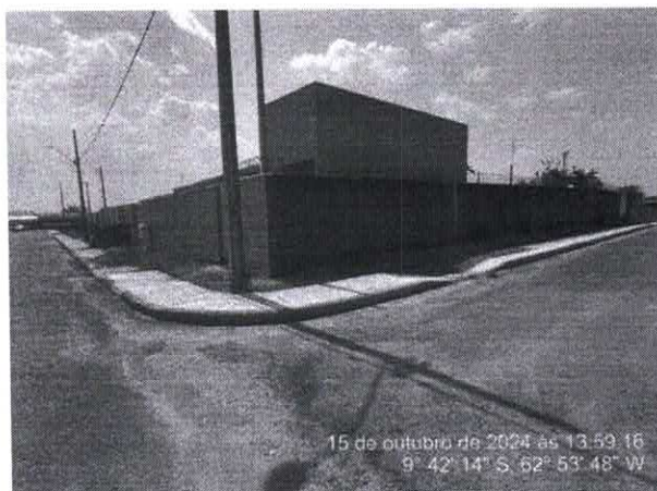
Foto 17 – Av Sebastião Dutra
