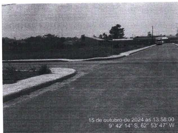
Foto 13 – Rua Oiti – Parte 01
