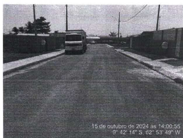
Foto 24 – Rua Oiti – Parte 02
