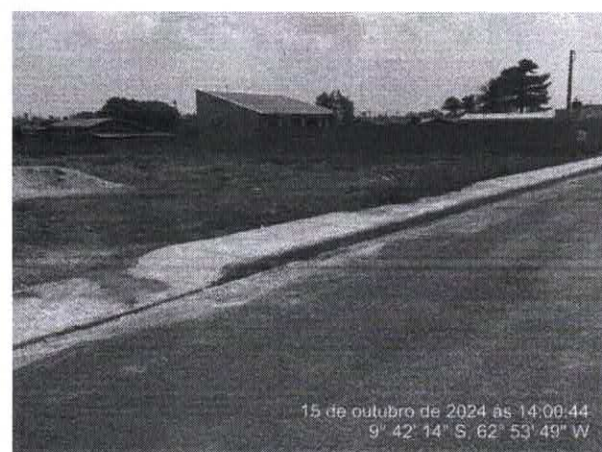
Foto 22 – Rua Oiti – Parte 02
